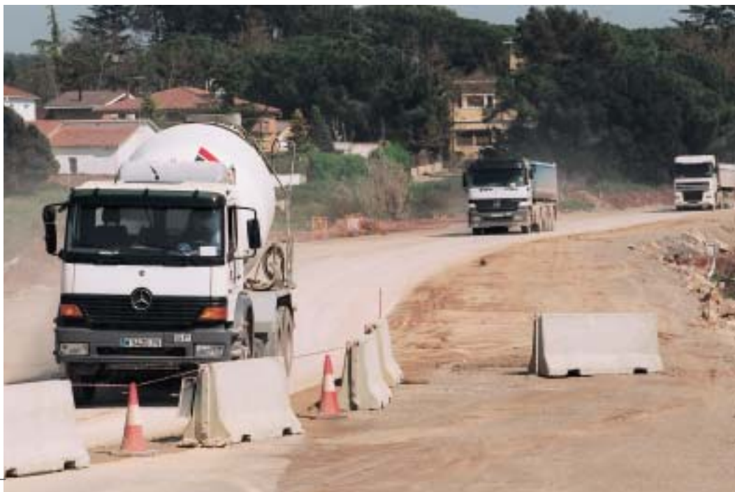
Camions circulant per la variant de Begues en obres
